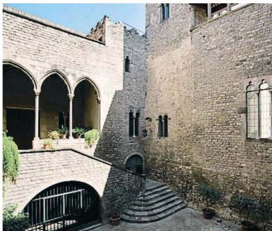
Arriba, patio interior del Palau Requesens, sede de la Real Academia de las Buenas Letras desde 1917, hace ahora cien años. Abajo, patio de entrada al edificio
